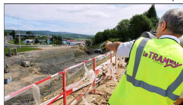
Le 15 juin, cela fera un an que le préfet signale la déclaration d'utilité publique du tramway. Depuis, le chantier a bien avancé. PHOTO LUDOVIC LAUDE
